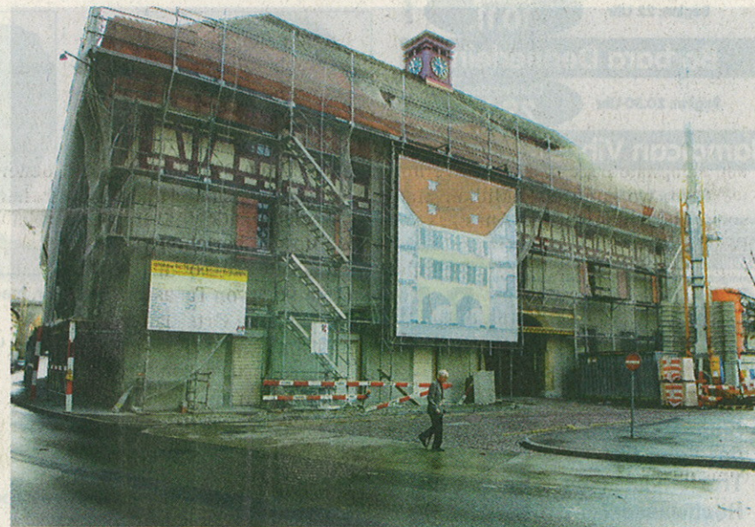
Güterhof vom Freien Platz aus betrachtet: Wenn das Wetter mitmacht, soll das Baugerüst noch vor Weihnachten abgebaut werden können.
